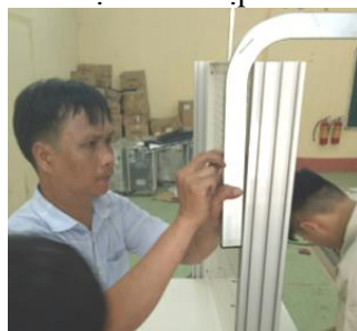
Hình 7. Lắp ráp khung mô hình
